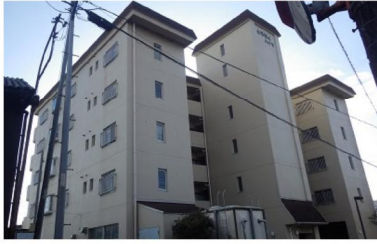
改修工事の設計を行った町営住宅とうはくハイツ
