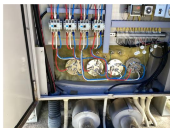
電気温水器1・2号機修繕
