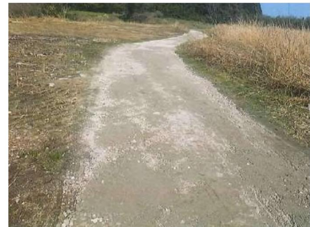
施工後：搬入場所付近
