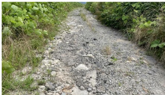
施工前：搬入場所付近
