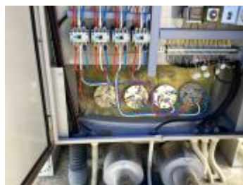
電気温水器1・2号機修繕
