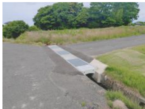
伊勢野地区水路改修工事（施工後）
