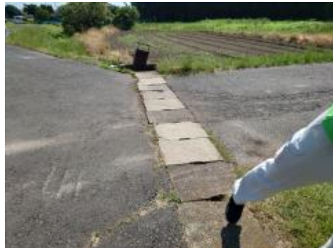
伊勢野地区水路改修工事（施工前）
