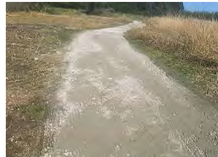
施工後：搬入場所付近
