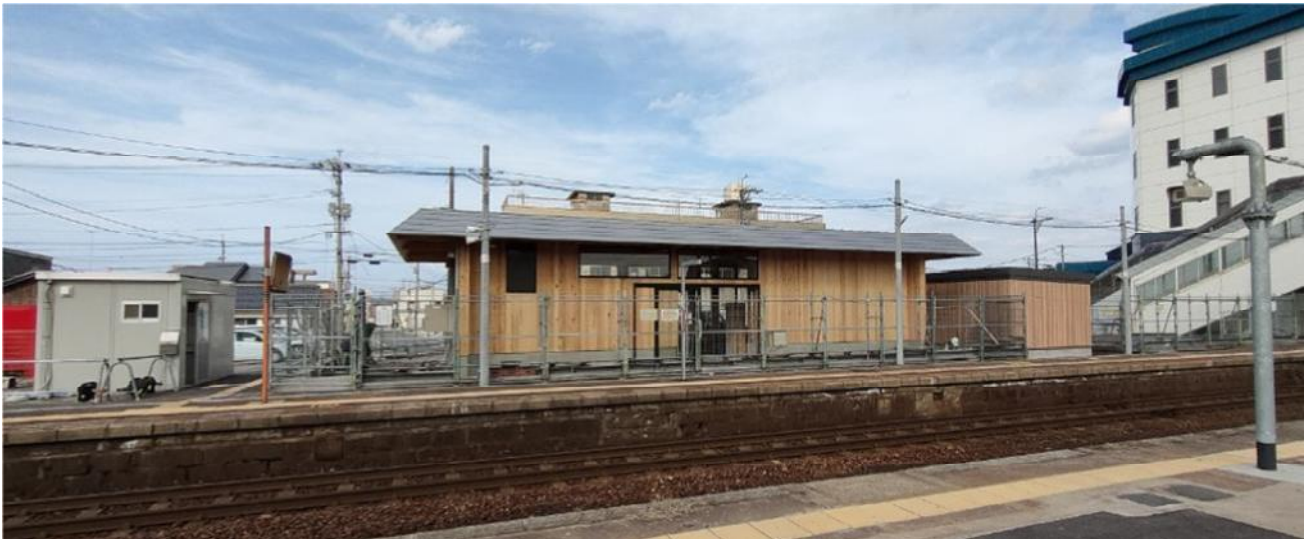
R8.2.5 南側から撮影 中央：浦安駅北待合所
