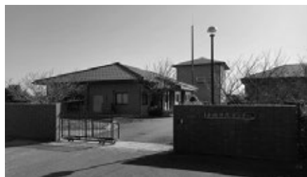
赤碓浄化センター（笹津）
