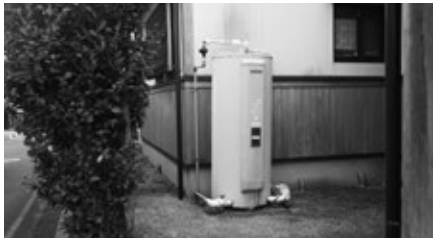
槻下団地の更新工事を行う給湯器
