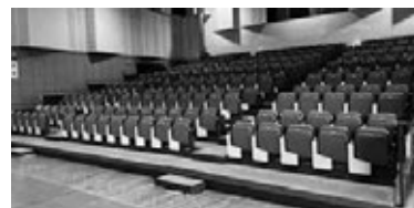
多目的ホール 可動椅子 制御盤更新
