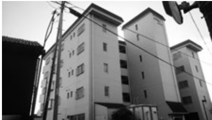
改修工事を行う町営住宅とうはくハイツ
