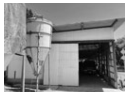
施設（牛舎）整備
