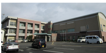
赤碕地域コミュニティセンター(分庁舎)外観
