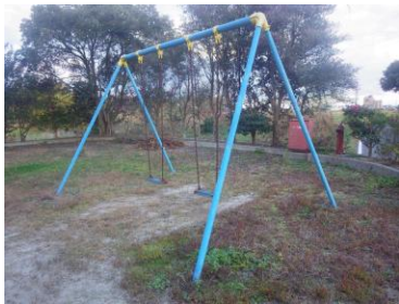
撤去を行う一里松団地遊具
