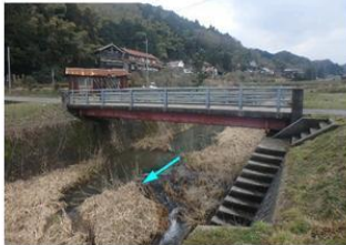
松木渡橋（下流から望む）
