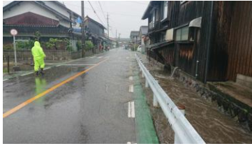
令和3年7月豪雨三保地区（町道光好丸尾線）の冠水状況
