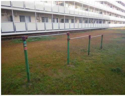
撤去を行うコーポラスことらの遊具
