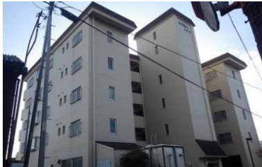
改修工事を行う町営住宅とうはくハイツ
