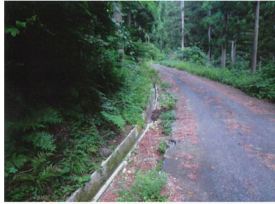
林道本谷線水路等復旧工事（着工前）
