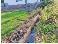
槻下地区水路修繕工事
