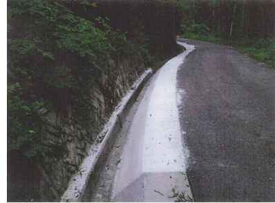
林道本谷線水路等復旧工事（完成後）
