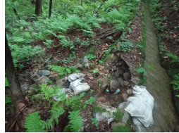
大父地区水路修繕工事
