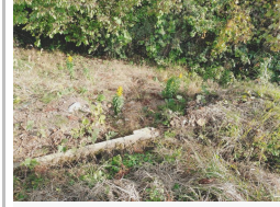
大父地区法面修繕工事
