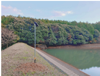
別所第1ため池に設置されたカメラ
