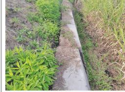
槻下地区水路修繕工事
