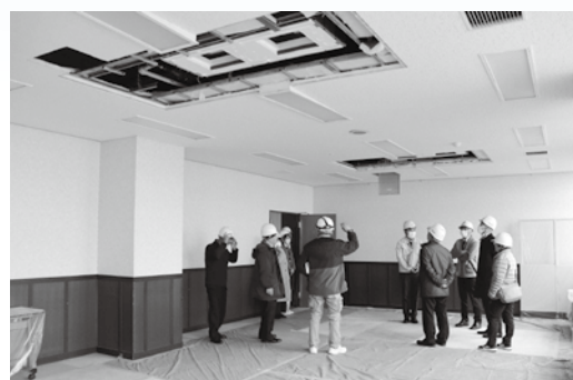
生涯学習センター空調改修
