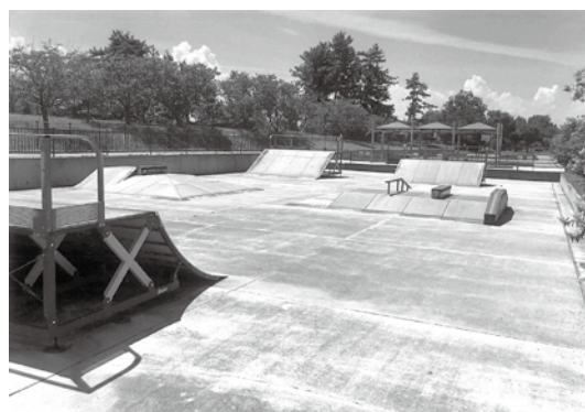
米子市 弓ヶ浜公園スケートボードパーク
