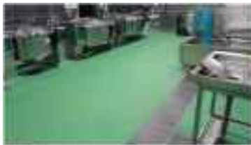
調理室床補修工事
