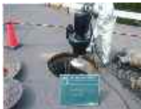
マンホールポンプ更新工事
