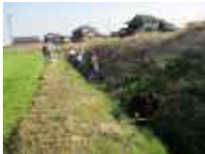
水路清掃作業（東伯水土里保全会）
