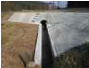
施設の長寿命化・水路更新（上中村地域資源景観保全活動組織）
