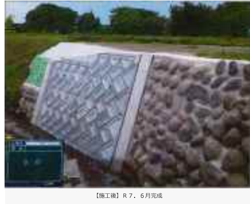
【施工後】 R 7. 6月完成
