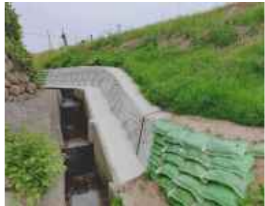
【施工後】 R 7. 5月完成
