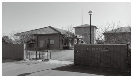
赤碓浄化センター(笹津)
