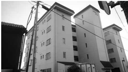
改修工事の設計を行う町営住宅とうはくハイツ
