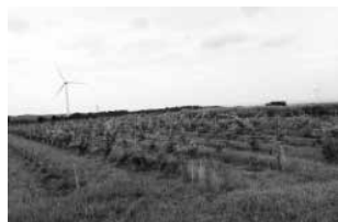
かん水設備・果樹棚整備
