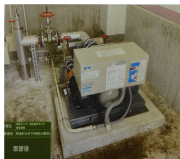
加圧給水ポンプ取替工事
