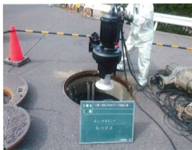
マンホールポンプ更新工事
