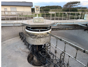
東伯浄化センター浚渫
