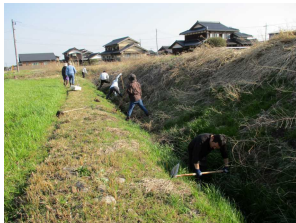
水路清掃作業（東伯水土里保全会）
