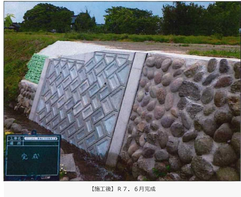
【施工後】 R 7. 6月完成
