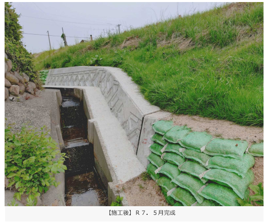
【施工後】 R 7. 5月完成
