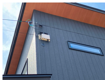
光ケーブル引込み、ONU設置後
