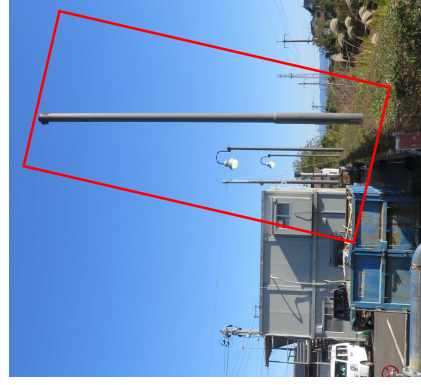
代替照明設置候補
