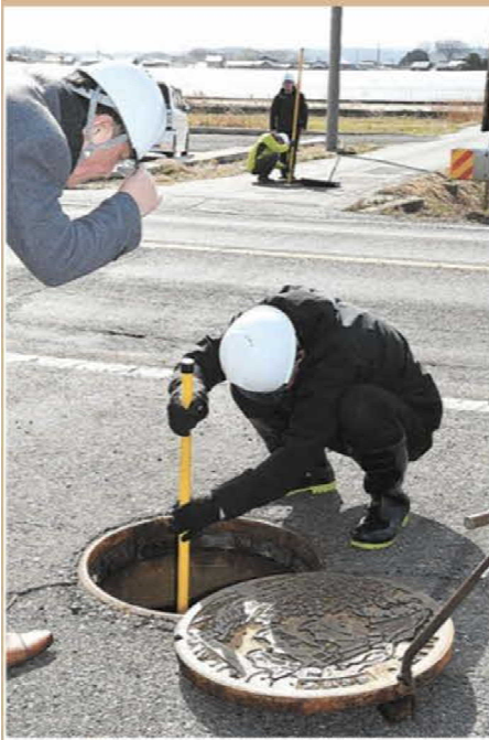
下水道管の内部を確認する職員ら＝14日、琴浦町鮎津
