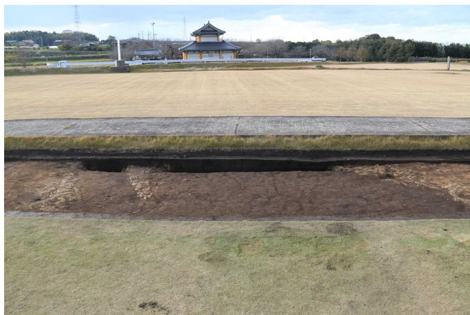
土取り穴(トレンチ43)
