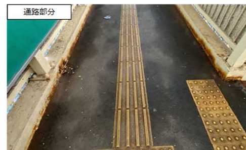
劣化程度：4 状態：欄木に錆が発生し腐食が進行し、部材欠損
