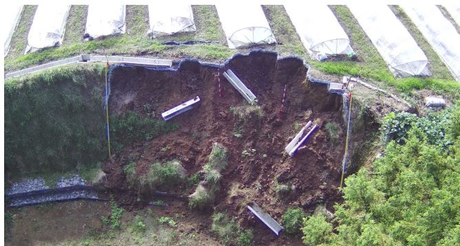
令和5年災 33-1金屋地区災害復旧工事(現在施工中)
