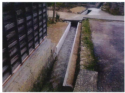
施設の長寿命化・水路の更新 (槻下地域資源・景観保全活動組織)
