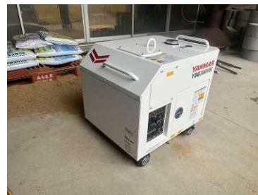
総合体育館設置状況
