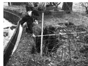
右岸側護岸裏が陥没している普通河川谷川
