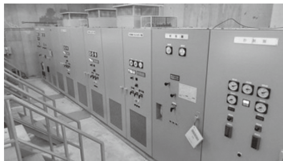
第一揚水機場操作盤内インバータの交換
