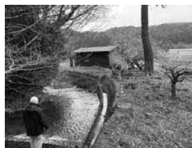
右岸側護岸裏が陥没している普通河川谷川
