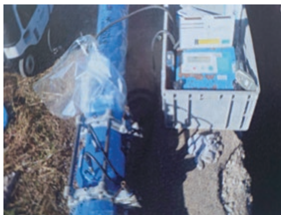
▲耐震管への更新工事の様子
