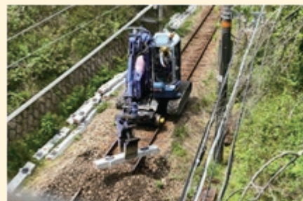
機械施工によるまくらぎ交換 (木製⇒コンクリート製)の様子
