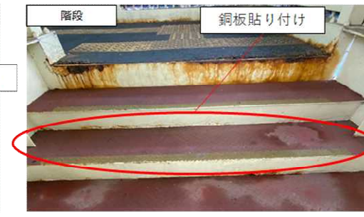
劣化程度：5（銅板貼り付け前） 状態：元の板に穴が開いているため、銅鋼板を貼り付け
