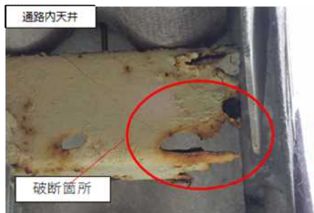
劣化程度：4～5（番線対応前） 状態：屋根を支えている鉄骨の腐食および鉄骨と屋根を止めるフックボルトの腐食がすすみ破断しているため、一部番線で固定している
