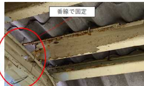
劣化程度：4～5（番線対応前） 状態：屋根を支えている鉄骨の腐食および鉄骨と屋根を止めるフックボルトの腐食がすすみ破断しているため、一部番線で固定している
