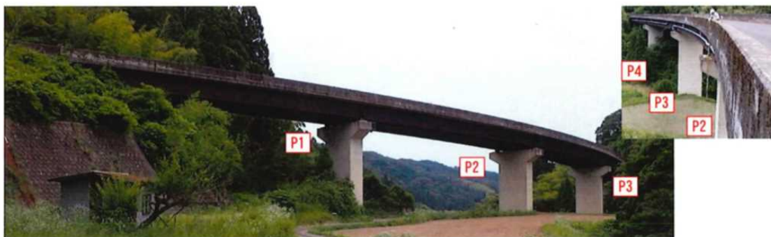
新技術を活用し点検を行う赤松橋（町道倉坂福永線）
