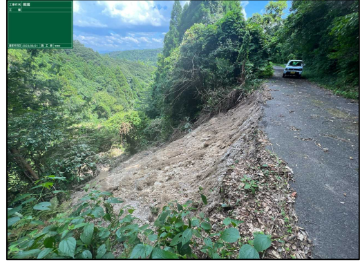
33-204槻下地区 水路法面崩落
