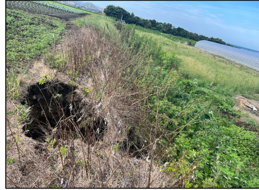
33-204槻下地区 水路法面崩落
