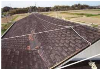
一里松団地 屋根の劣化、破損状況
