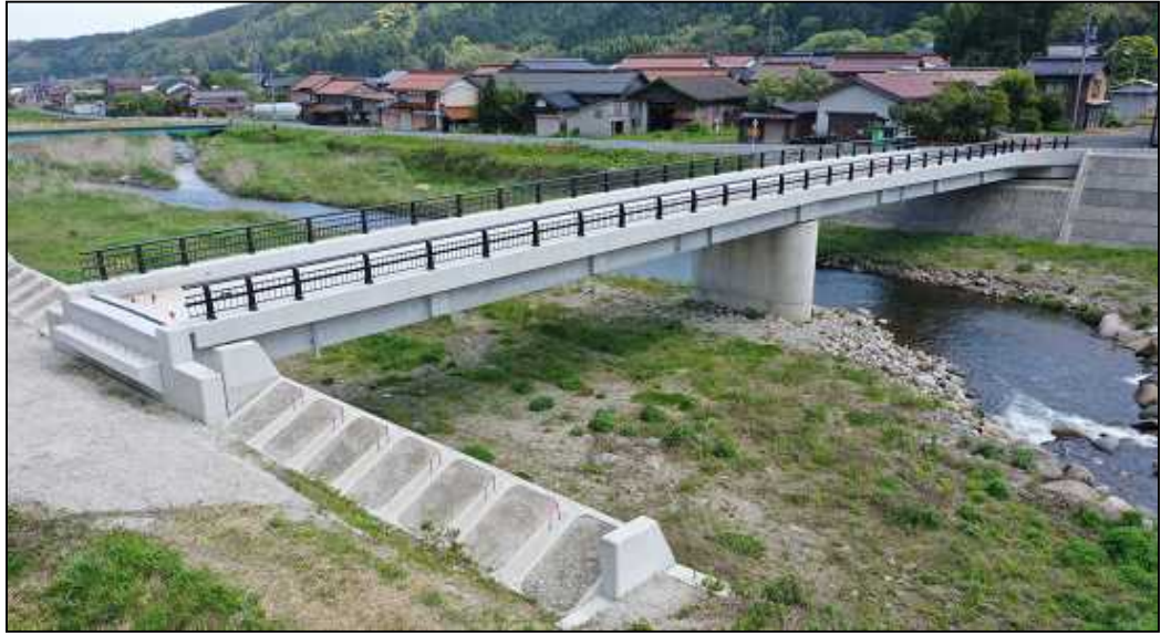
大山橋の状況（【左奥】旧橋、【中央】新橋）
