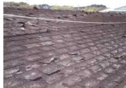
一里松団地 屋根の劣化、破損状況
