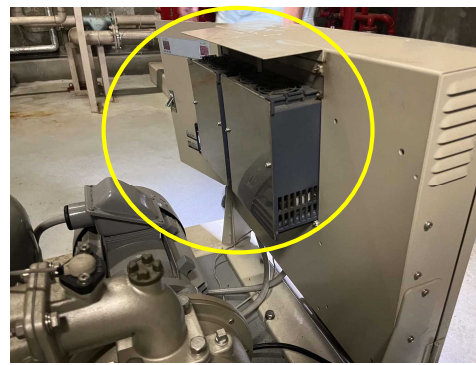
冷却ファン (左側は停止中。右側は仮設したもの)
