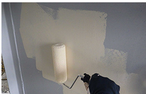
『長期耐候性錆転換防食塗装システム』【NETIS QS-210056-A】
