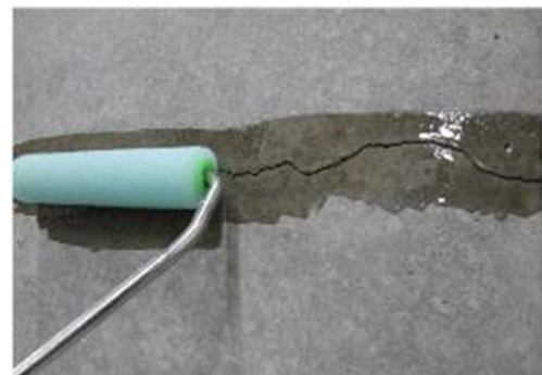
『ひび割れ補修浸透性エポキシ樹脂塗布工法』【NETIS CB-130007-VE】
