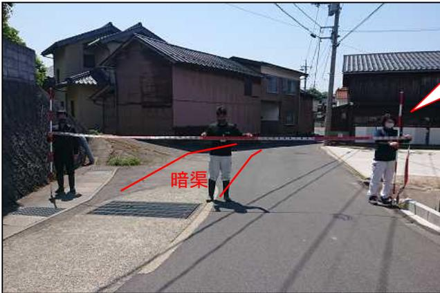
暗渠排水管を道路側溝に改修することで、豪雨時に道路が冠水し、人家が床下浸水するのを防止する。
