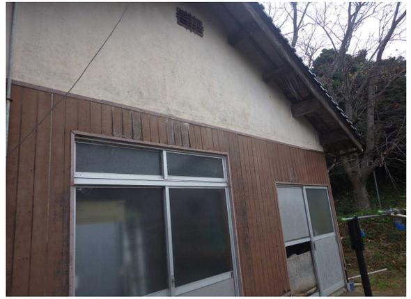
朝日ヶ丘集会所 外壁、屋根野地板破損状況
