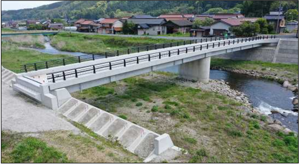
大山橋の状況（【左奥】旧橋、【中央】新橋）
