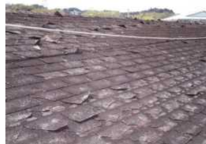
一里松団地 屋根の劣化、破損状況
