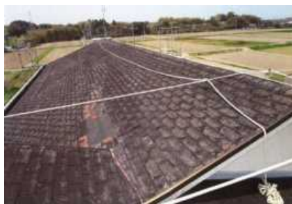
一里松団地 屋根の劣化、破損状況
