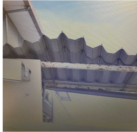
【赤碓中学校渡り廊下屋根】
