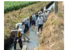
水路の泥上げ
