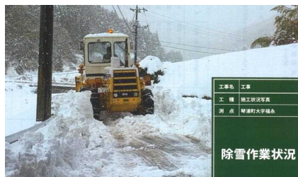
現在使用中のドーザー (東伯方面作業) 昭和53年配備
