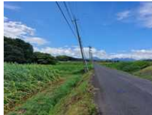
〈強風と地盤の緩みによる傾き〉
