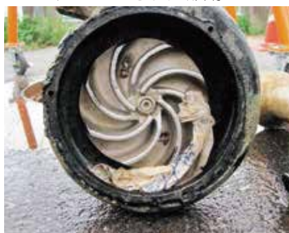
マンホール内のポンプに タオルがからまり故障停止
