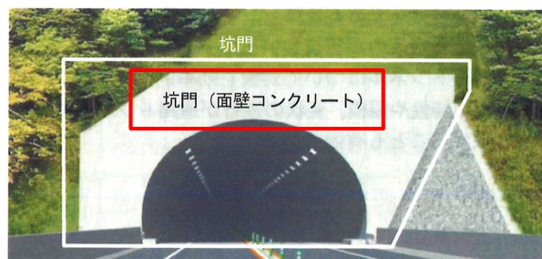
図 3.1 トンネル点検箇所（本体工・附属物）
