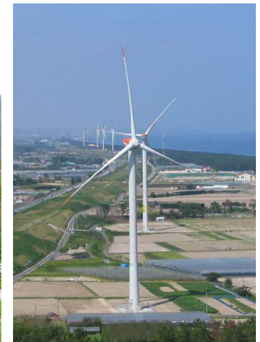
北条砂丘風力発電所
