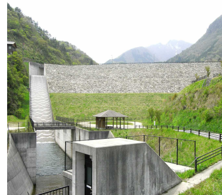
船上山発電所
