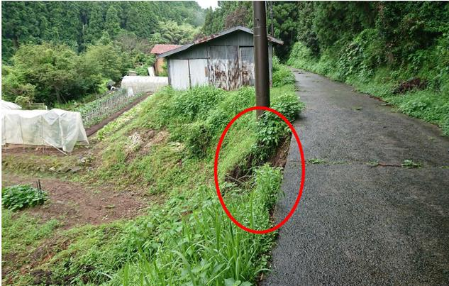
町道大成開拓五号線（岩本）の法面崩壊
