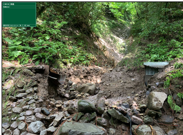
農業用山腹水路の脱落（三本杉）
