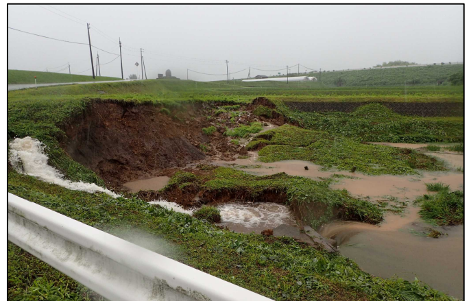
ため池（柳堤）への崩落（松谷）
