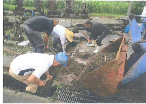
水路に堆積した土砂の撤去（三保地区）
