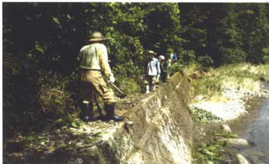
二水系の用水路で土砂撤去を実施
