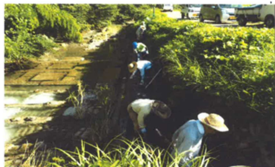
二水系の用水路で土砂撤去を実施
