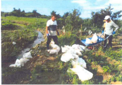
水路法面を土のうで補修（三保地区）
