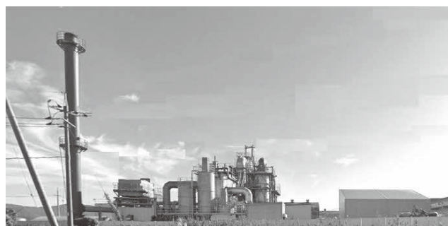
参考 江島（島根県）にある産廃処理工場
