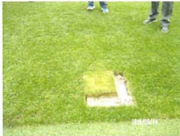
鵜住居復興釜石スタジアム 散水栓のマンホール保護で人工芝は安全性がない
