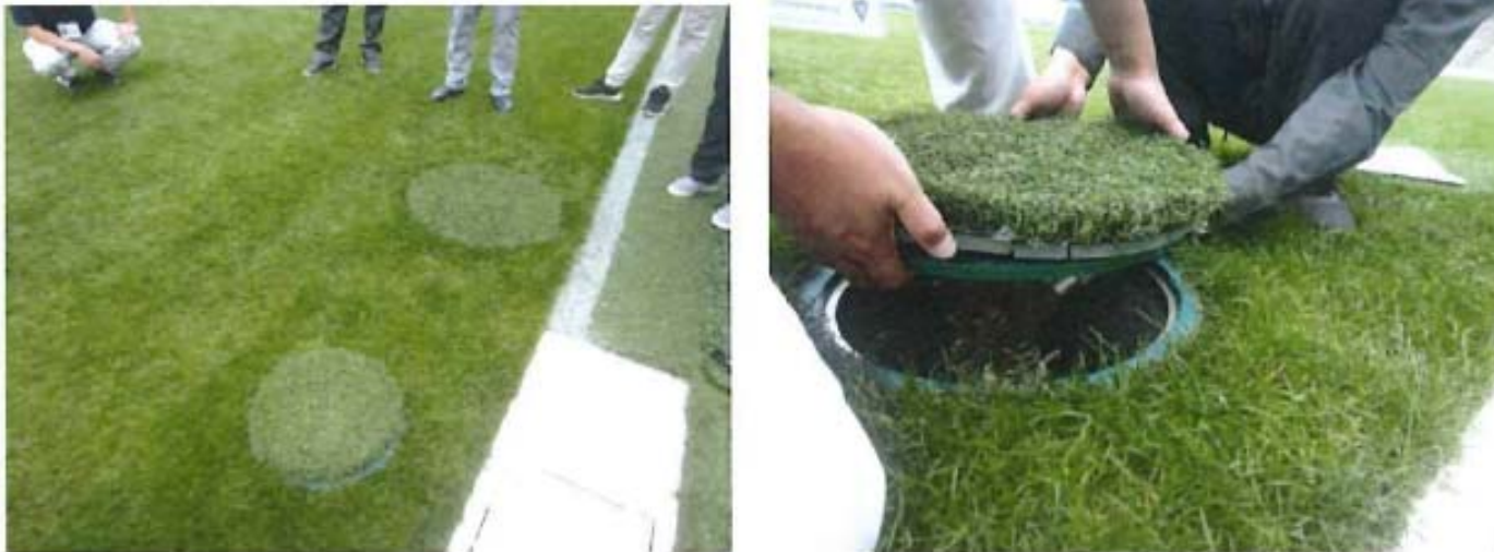
鵜住居復興釜石スタジアム 散水栓のマンホール保護で人工芝は安全性がない
