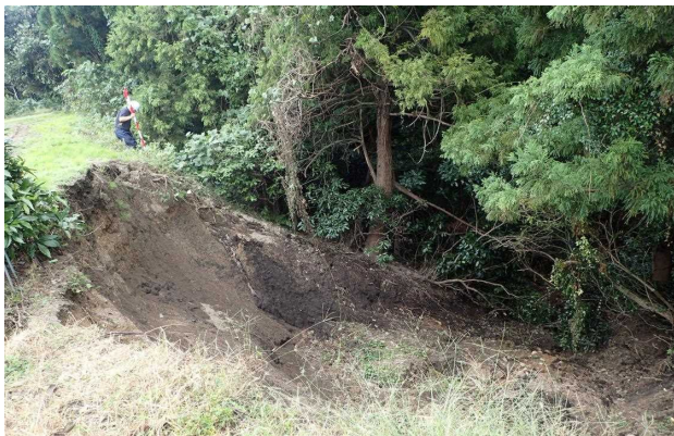
農地災害復旧工事（319公文地区災害復旧工事）
