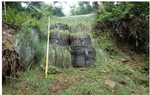
農業用施設災害復旧工事（206-3倉坂地区災害復旧工事）
