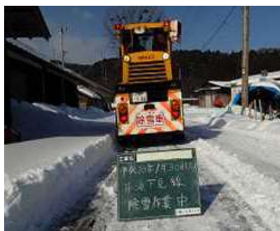
現在使用中のロータリー
