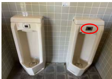
八橋農村公園 センサー部の故障
