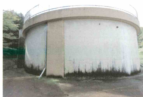
大父木地配水池
