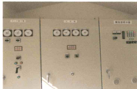
大父木地水源地 緊急遮断弁盤等
