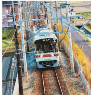
写真1 鉄軌道建設(中野)駅構内
